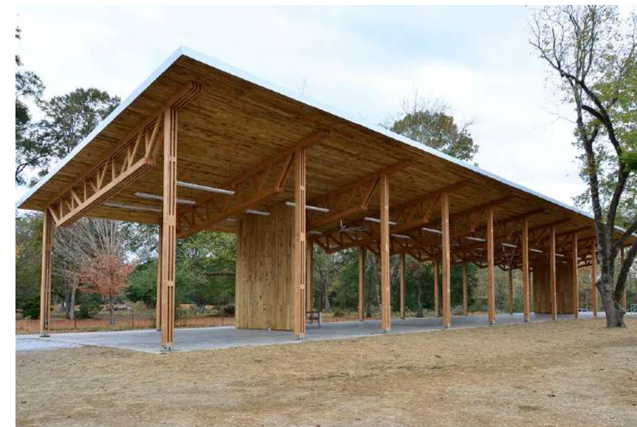
Figura 45: Rural Studio | Pavilhão de Fabrication | FONTE: https://archinect.com .
